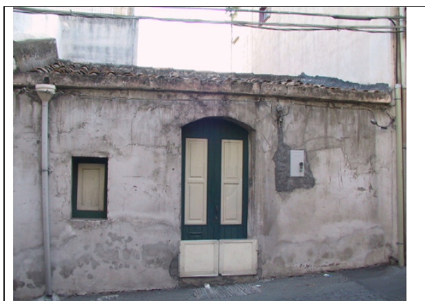
Figura 1 -- Casa terrana tipo: superficie del lotto pari a 47mq circa; larghezza dell'edificio su fronte stradale 5,7m; rapporto di copertura 100%; rapporto di permeabilità 0%; altezza dell'edificio su fronte stradale 3 m. Il corpo di fabbrica è allineato con il fronte stradale. Iff 4 mc/mq.
