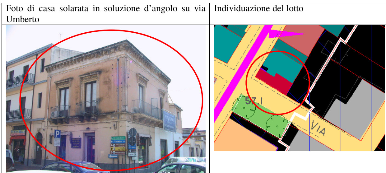
Figura 7 -- casa solarata in soluzione d'angolo tipo del tessuto A L1 . Superficie del lotto pari a 88mq; rapporto di copertura pari a 100%; rapporto di permeabilità pari a 0%; altezza dell'edificio su fronte stradale pari a 8m.
