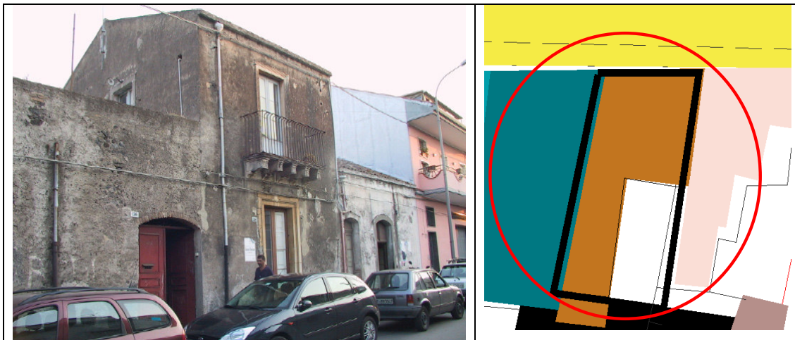
Figura 2 -- Casa terrana tipo: superficie del lotto pari a 147mq; larghezza dell'edificio su fronte stradale 8m; rapporto di copertura 65%; rapporto di permeabilità 15%; altezza dell'edificio su fronte stradale 4,5 m. Il corpo di fabbrica è allineato con il fronte stradale. Iff 3 mc/mq.
