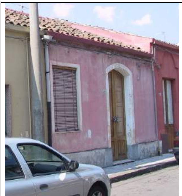
Figura 1 -- Casa terrana tipo: superficie del lotto pari a 130mq; larghezza dell'edificio su fronte stradale 5,8m; rapporto di copertura 93%; rapporto di permeabilità 0%; altezza dell'edificio su fronte stradale 4 m. Il corpo di fabbrica è allineato con il fronte stradale. Iff 3,7 mc/mq.
