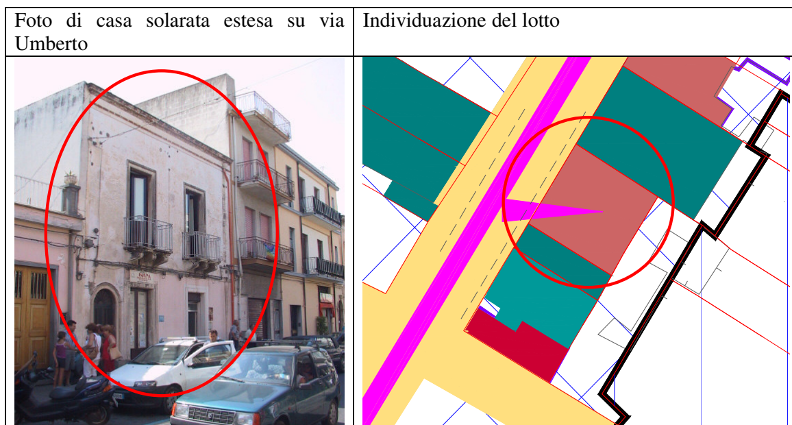
Figura 6 -- casa solarata estesa tipo del tessuto A L1 . Superficie del lotto pari a 222mq; larghezza su fronte stradale pari a 14,5m; rapporto di copertura pari a 100%; rapporto di permeabilità pari a 0%; altezza dell'edificio su fronte stradale pari a 8,5m.
